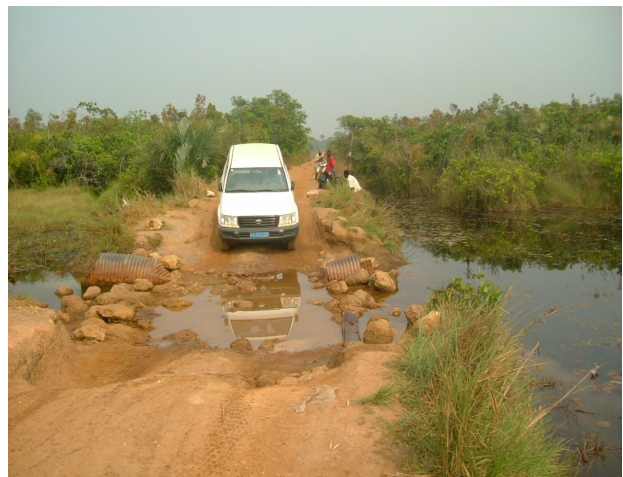
Schlechter Zustand Straßen
